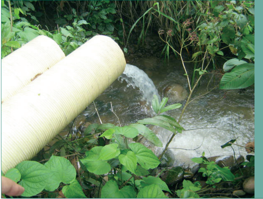
Figura 2.3 Vertimiento de aguas residuales domésticas a un cuerpo de agua.
